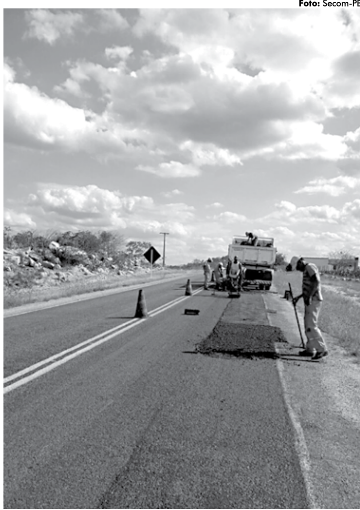
Equipes utilizam mistura betuminosa nos serviços de tapa buracos nas rodovias
